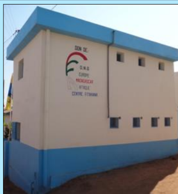
Bloc sanitaire construit par l'ONG EMA au centre du village en 2014
